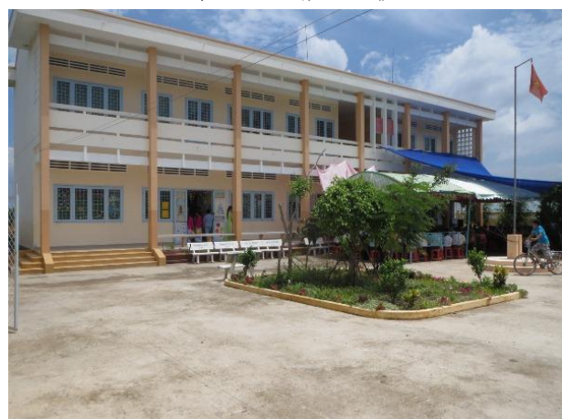
本件で整備された6教室を有する校舎
